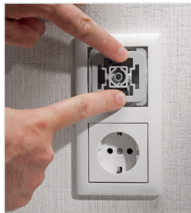
Bild 18: Der Abdeckrahmen des Installationssystems wird aufgesetzt.
