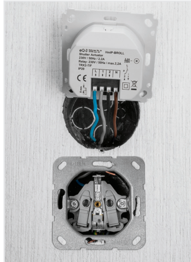
Bild 16: Der fertig verkabelte Aktor ...
