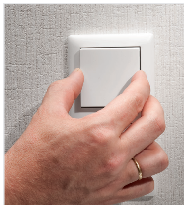
Bild 19: Abschluss der Installation: Einsetzen der Tasterwippe
